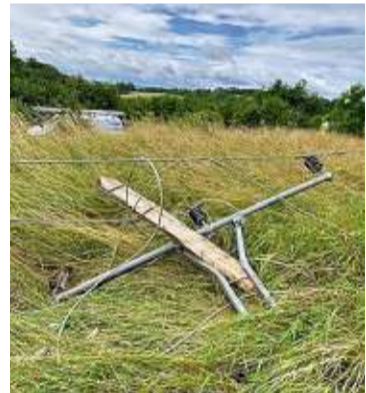
Sturmschaden FOTO: MITNETZ STROM
